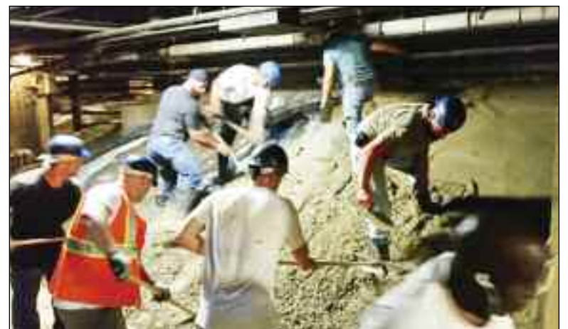
Trabajadores de NYCHA del Local 237 usan cemento para detener la población de ratas — literalmente, en sus pistas, en Patterson Houses.
